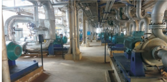
中海油中捷石化TCE ( OH 2 ) 泵 CNOOC ZOJE Petrochemical Co., Ltd. TCE(OH 2 ) Pump
