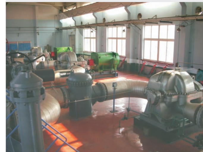
海洋石油绥中36-1项目原油泵 CSPEC Suizhong 361 Project (KSY1500-84 1500m 3 /h@84m@630kw)
