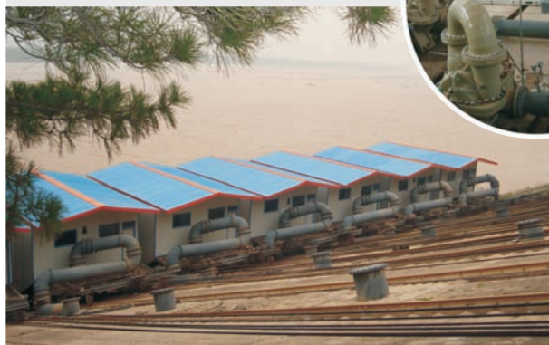
大禹渡引黄工程提水泵 Dayudu Yellow River Project (KSY1900-105x2 1900m³/h@210m@1400kw)
