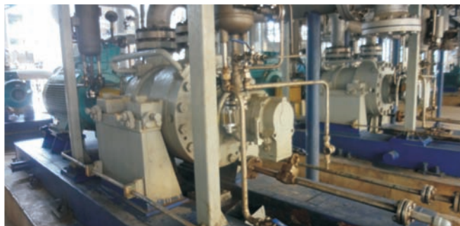
大连福佳·大化石油化工有限公司脱乙烷塔进料泵 Dalian Fukuyoshi-Dahua Petrochemical Co. Ltd. Deethanizer Feed Pump TDC80-240/6(Q=85.3m 3 /h,H=418m,P=90KW)
