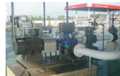
中石化长岭分公司柴油泵 Sinopec Changling Co.,Ltd TSY200–150–460(Q=500m³/h H=60m P=110KW)
