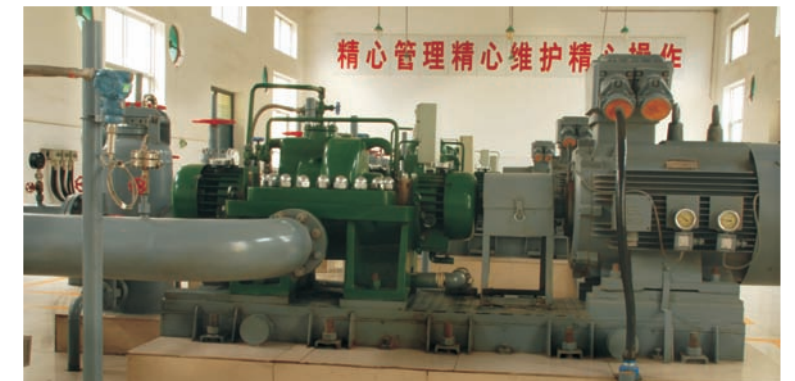
中石化广东石油分公司仓储分公司汽油泵 Sinopec Oil Stock Guangdong Co (KDY300–100x5 300m³/h @ 500m @ 560kw)
