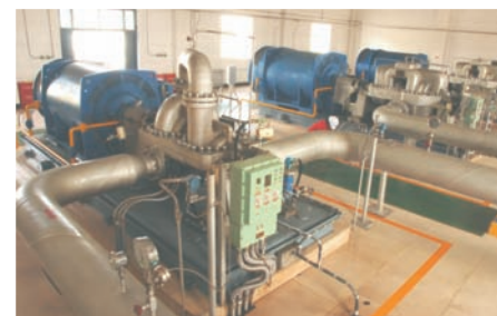
长庆输油公司惠安堡输油站 Huianpu Oil Pumping Station Changqing (KDY700–90x5 700m³/h @ 450m @ 1250kw)
