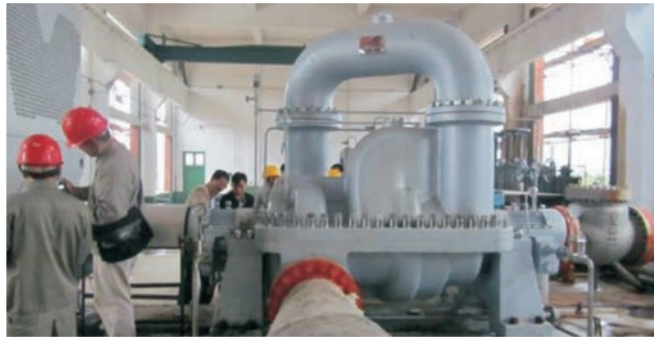
中国石油化工股份有限公司长岭分公司 800万吨/年常减压装置原油泵 Changling branch of Sinopec 8 million tons/year Crude Distillation Unit KDY1100-100×3 ( Q=1100m 3 /h,H=300m,P=1400KW )
